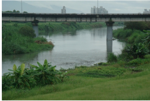
圖 2 宜蘭河中山橋附近河道狀況及微波雷達表面流速儀架設位置(三角形標誌)；右岸 sensor 1，左岸 sensor 2
